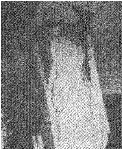
*(a) Desprendimiento y caída del concreto en la parte superior de la columna, exposición del acero de refuerzo longitudinal en una zona relativamente grande. Agrietamiento severo paralelo al refuerzo longitudinal, que se extiende hasta la parte central de la columna.*
