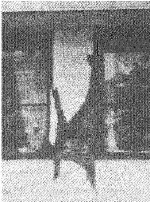
*(a) Doblez del acero de refuerzo longitudinal, degradación y desprendimiento del concreto en el núcleo, se aprecia la aparición de deformación vertical en la columna.*
