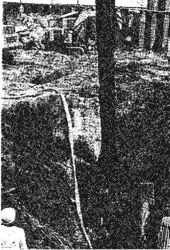
**Fotografía Apéndice 3** *Excavación de un pilote de concreto reforzado dañado por licuación*
