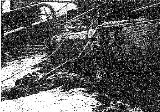
**Fotografía Apéndice 5** *Tanque de productos farmacéuticos y daño en tubería por licuación (sismo de la costa de Tokachi, 1968)*
