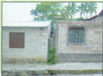
Separación entre viviendas o junta de dilatación
