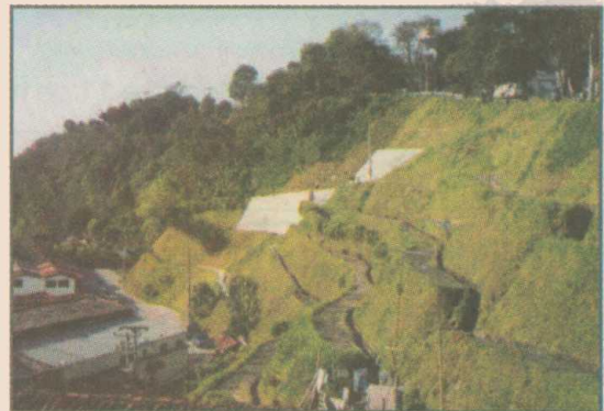
TRABAJOS DE MANTENIMIENTO REALIZADOS EN LA LADERA DE CHIPRE
