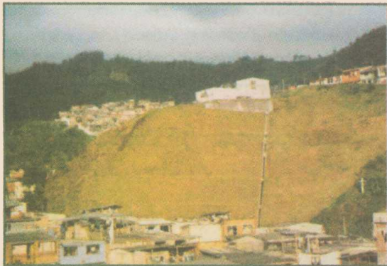
TRABAJOS DE MANTENIMIENTO REALIZADOS EN LA OBRA DEL BARRIO COMUNEROS.
