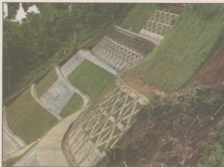
SECTOR LADERA DE CHIPRE. TRATAMIENTO DE ESTABILIDAD EN EJECUCIÓN.
