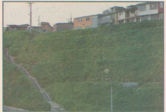
TALUD BARRIO LA ASUNCIÓN. (FOTOGRAFÍA TOMADA DESPUÉS DEL TRATAMIENTO DE ESTABILIDAD).
