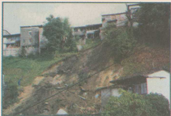
BARRIO COLOMBIA. SITIO AFECTADO POR EL DESLIZAMIENTO DEL 18/19 DE MARZO (FOTOGRAFÍA TOMADA EL 19 DE MARZO).
