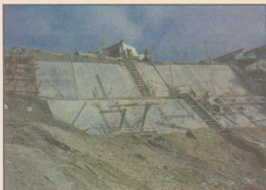
BARRIO LA SULTANA. TRATAMIENTO DE ESTABILIDAD EN EJECUCIÓN.
