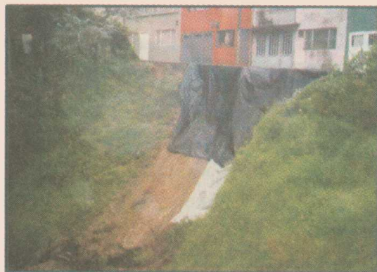
BARRIO VILLA DEL RÍO. SITIO AFECTADO POR EL DESLIZAMIENTO DEL 28/29 DE OCTUBRE (FOTOGRAFÍA TOMADA EL 29 DE OCTUBRE).
