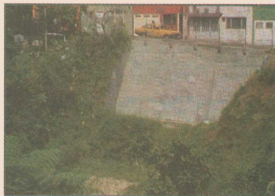
BARRIO VILLA DEL RÍO. (FOTOGRAFÍA TOMADA DESPUÉS DE CONSTRUIR LA OBRA DE ESTABILIDAD).
