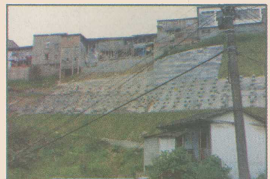
BARRIO COLOMBIA. (FOTOGRAFÍA TOMADA DURANTE LA CONSTRUCCIÓN DE LAS OBRAS DE ESTABILIDAD).
