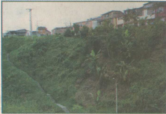
TALUD BARRIO LA ASUNCIÓN. ANTES DEL TRATAMIENTO DE ESTABILIDAD.
