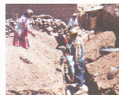
Proceso cimentación de vivienda
