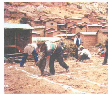
Limpieza del terreno y trazo
