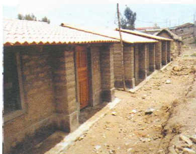
Viviendas terminadas Calacoa detalle de mochetas
