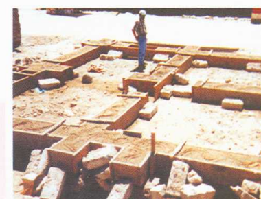
Encofrado llenado sobre cimiento
