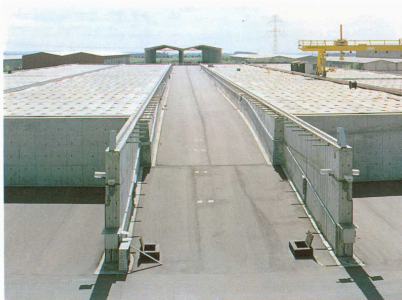
Evacuación regional de desechos de actividad baja en Dukovany (República Checa).
