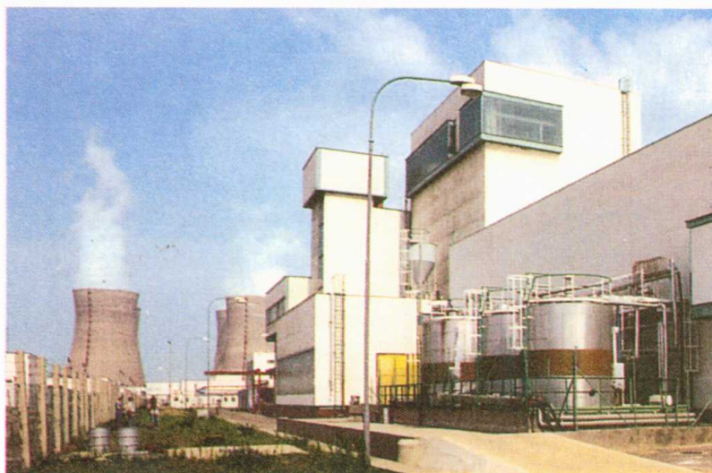
Planta de bituminación de desechos radiactivos provenientes de la central nuclear de Dukovany (República Checa).
