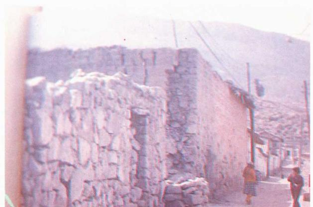
CONSTRUCCIONES DE ADOBE DEBILITADAS POR PASADOS SISMOS Y LA HUMEDAD DEL SUELO, QUE INCREMENTA LAS INTENSIDADES SÍSMICAS; LO QUE HACE DE ELLAS ELEMENTOS DE ALTO RIESGO. EN LA FOTO, UNA ALTA PARED DE ADOBE, SEPARADA DE LOS OTROS MUROS POR GRIETAS, AMENAZA A LOS TRANSEÚNTES QUE PASAN AL LADO DE ELLA.
