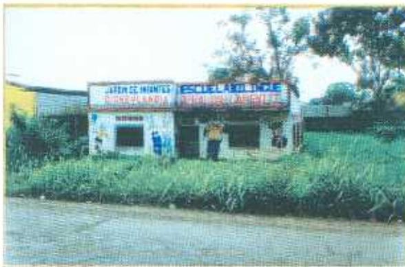
CONSTRUCCION DE ESCUELAS SOBRE RELLENOS DE BAJA ALTURA
