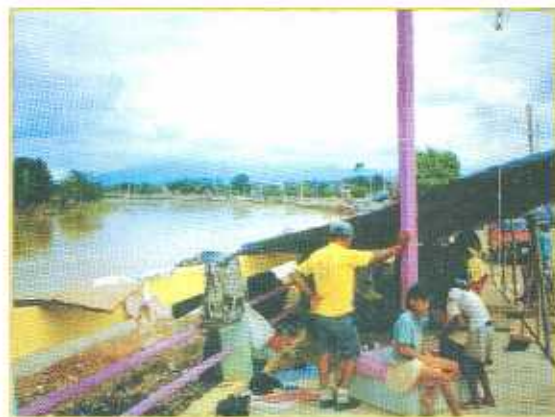
LA CONSTRUCCION DE MALECONES CON REDUCCION DEL CAUCE DE LOS RIOS
