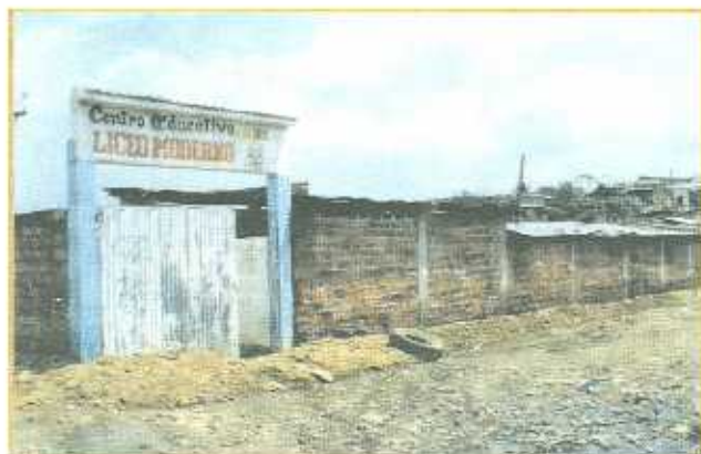
EL RELLENO Y LA PAVIMENTACION DE LAS CALLES DESPUES DE LA CONSTRUCCION DE LAS EDIFICACIONES ESCOLARES
