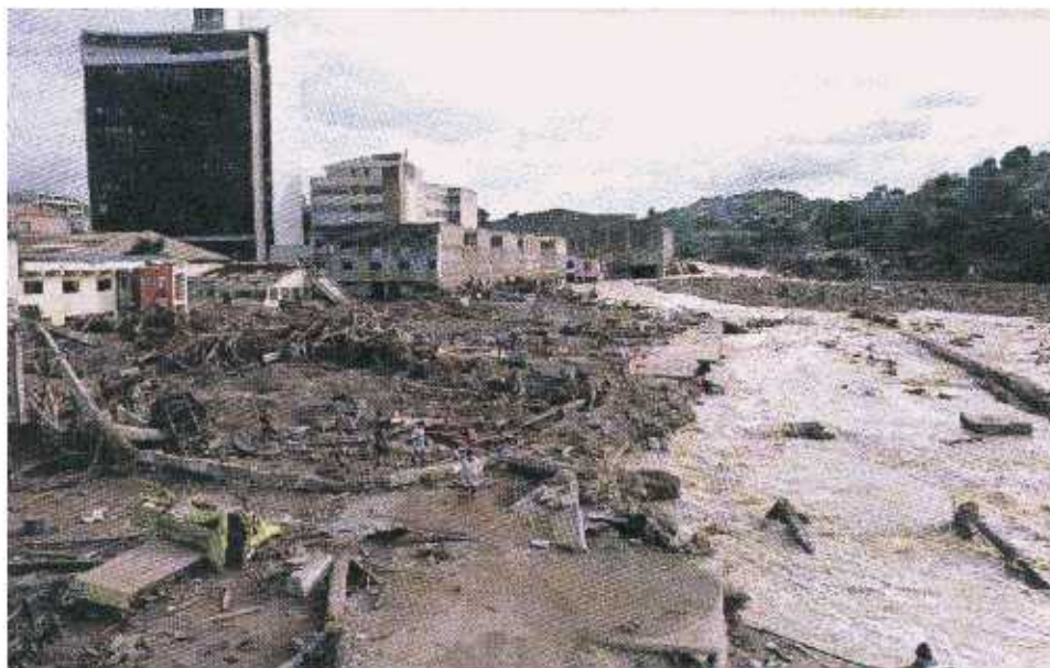
Varias zonas de la ciudad de Tegucigalpa fueron destruidas totalmente durante el huracán Mitch en 1998. Foto: cortesía de la Comisión Permanente de Contingencias (COPECO).
