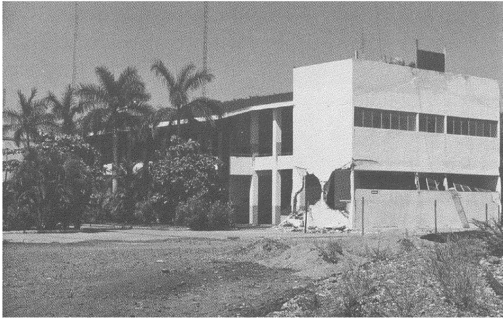
Foto 12.- Edificio del Ayuntamiento después del sismo de 1985 [1].
