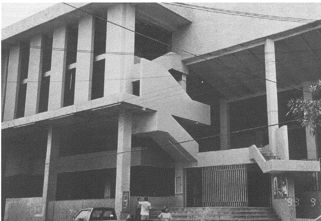
Foto 25.- Vista actual de la estructura. Los muros de mampostería dañados fueron removidos.
