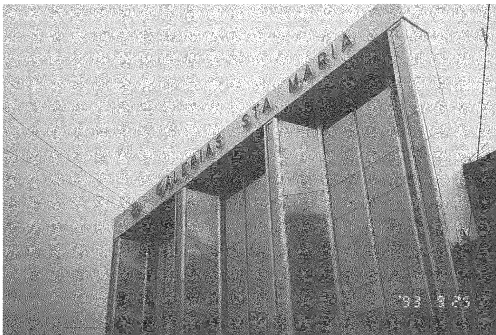
Foto 27.- Edificio Galería S.A. en septiembre de 1993.
