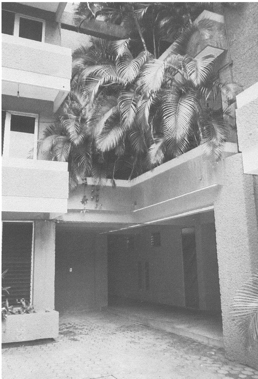
Foto 35.- Planta baja rehabilitada; visita en septiembre de 1993.
