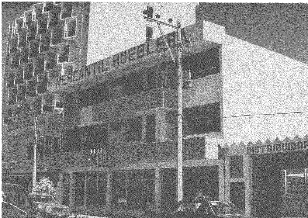
Foto 36.- Mercantil Mueblera posteriormente al sismo de 1985 [1].
