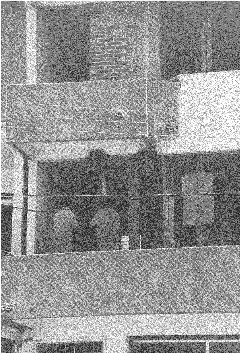
Foto 37.- Reconstrucción de los elementos confinantes en los muros de mampostería estructural [1].
