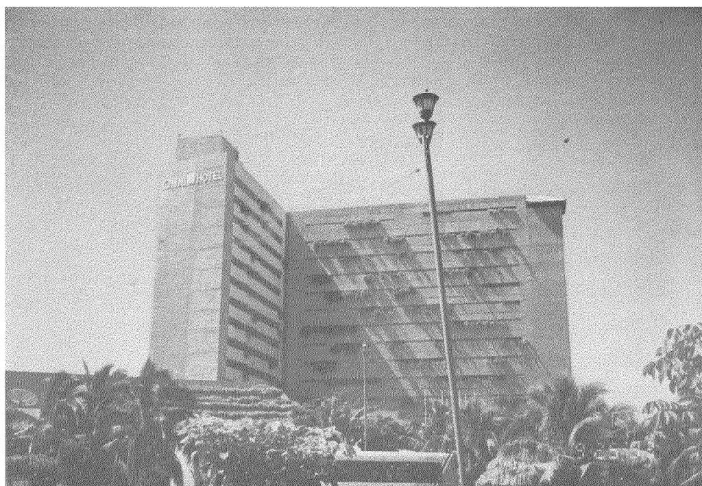
Foto 46.- Hotel Omni en septiembre de 1993 El edificio de la izquierda se construyó posteriormente al sismo de 1985.
