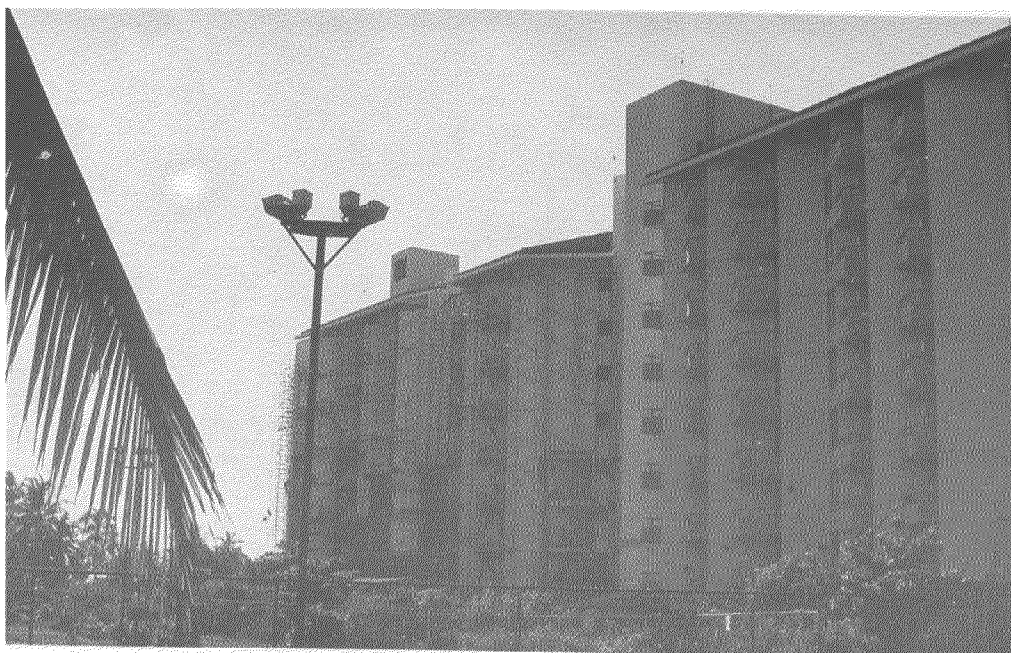
Foto 52.- Hotel Riviera del Sol durante los trabajos de reparación después del sismo de 1985 [1].
