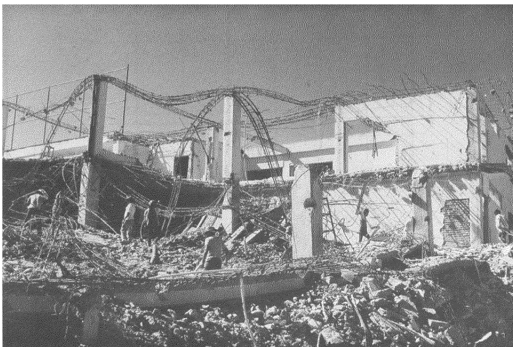
Foto 60.- Porción Noreste de la estructura severamente dañada en proceso de demolición [1]
