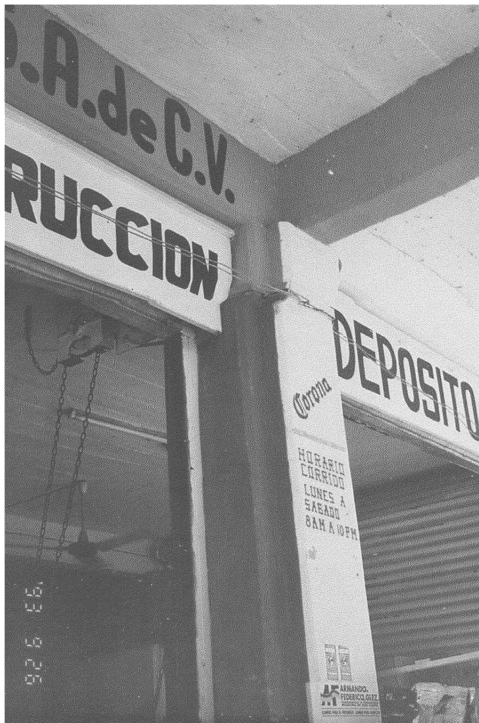
Foto 69.- Refuerzo en columna (columna de los ejes A-4).
