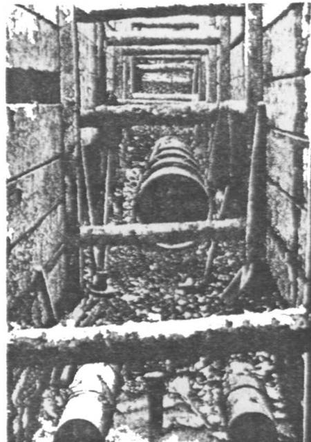
Tuberías de desagüe en una zanja con entibado horizontal
