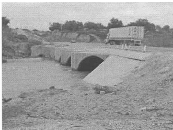
Figura 2.19 Vado del libramiento sur, vista hacia aguas abajo
