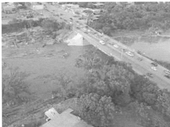
Figura 2.17 Puente de la carretera 57 en Villa de Fuentes, vista hacia aguas abajo
