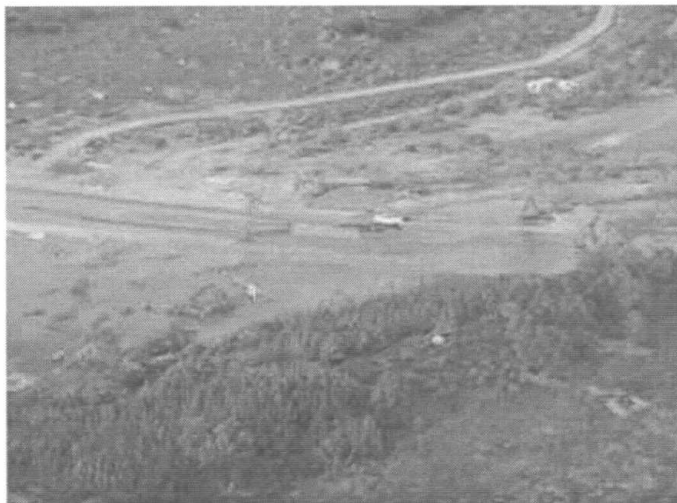
Figura 2.16 Vado del Libramiento "José López Portillo", vista hacia aguas abajo
