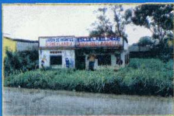
CONSTRUCCIÓN DE ESCUELAS SOBRE RELLENOS DE BAJA ALTURA
