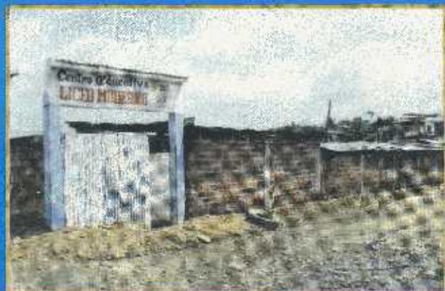
EL RELLENO Y LA PAVIMENTACIÓN DE LAS CALLES DESPUÉS DE LA CONSTRUCCIÓN DE LAS EDIFICACIONES ESCOLARES.
