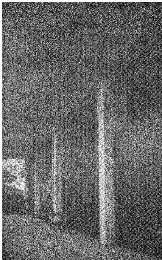
Colegio Calderón, Milagro - Guayas. La ausencia de un mantenimiento preventivo incrementa los daños. Es necesario realizar trabajos de impermeabilización de las cubiertas de hormigón para impedir el deterioro de la losa, instalaciones, etc.
