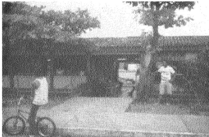
La escuela Simón Bolívar en Calceta-Manabi, se encuentra 50 centímetros por debajo del nivel de la acera. Se debe elevar 20 cm el nivel de los pisos de las aulas - construir cunetas para la canalización de las aguas lluvias y una estación de bombeo para la evacuación de las aguas que se estancan dentro de la escuela.
