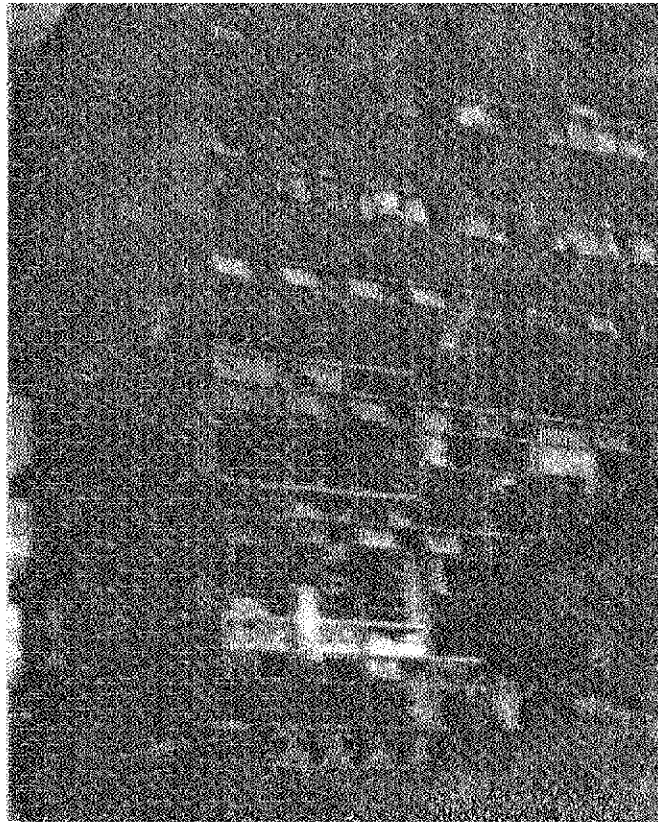
Fig.3 Daños secundarios significativos en edificio de 9 pisos. Hospital del Instituto Mexicano de Seguridad Social, México D.F., terremoto 1985.
