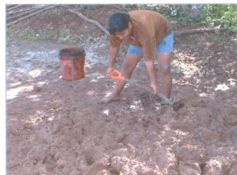
Al día siguiente revolver la mezcla y batir con los pies o con pala hasta quedar pastosa y del mismo color. Debe tener consistencia, no muy aguada, ya que se deforman los adobes al desmoldar.
