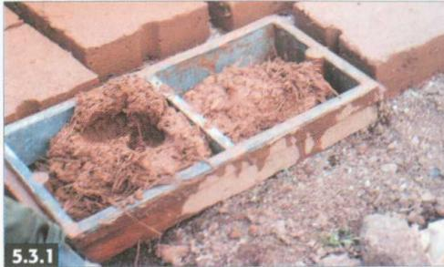
Formar una bola con lodo o mezcla tirarla con fuerza en el molde comenzando por las esquinas amasando bien para que quede compactado, sin vacíos.
