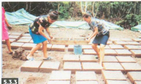
Retirar con cuidado el molde para no deformar el adobe recién hecho, luego limpiar el molde con un trapo mojado después de cada desmolde para que no se pegue la tierra.
