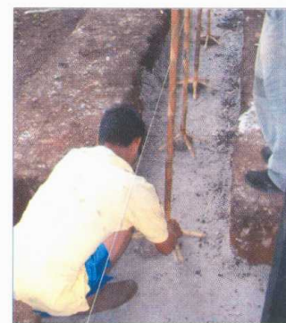
Colocación de varas para armaduría.
