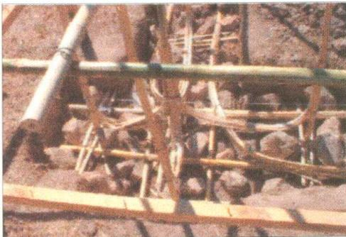
Detalle fundación de piedra y armadura.
