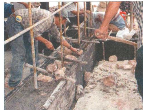
Colado de sobrefundación. Hacer el lleno colocando mezcla entre capa y capa de piedra.
