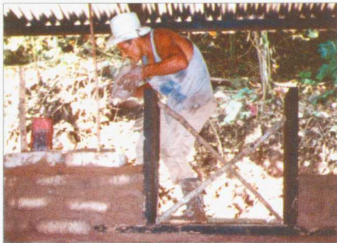
Colocación de marco de ventana.
