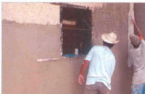
Segunda capa repellada (con plancha o codal de madera, ó a mano) proporción :1 bolsa de cal por 3 carretilladas de tierra y 1 de arena.
