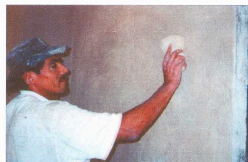
Picar nuevamente la superficie con tabla con clavitos ,luego afinar. Proporción: 4 de cal y 1 de tierra, (usando esponja).
