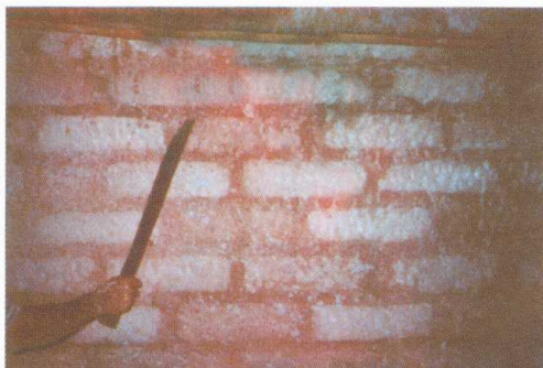
Picado, emparejado y limpieza de adobe. Luego mojar la pared para aplicar la primera capa.
