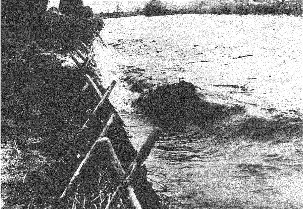
Figura 3.20 - Protección contra el oleaje con barreras de mimbreras
