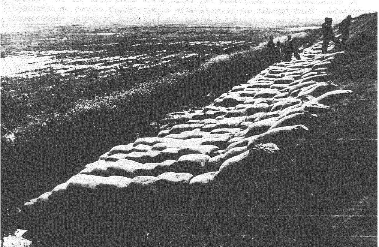
Figura 3.25 - Refuerzo del talud de una presa saturada, con hileras de sacos terreros
