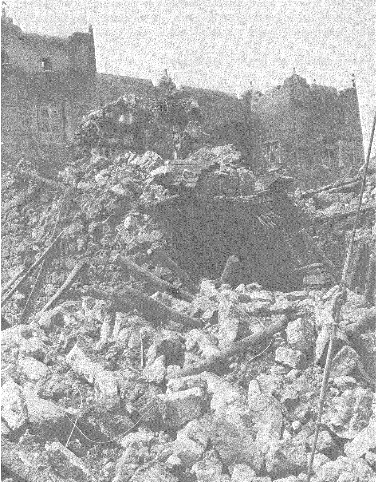
Figura 6 Una casa derruida en Mirbat, Sultanato de Oman
