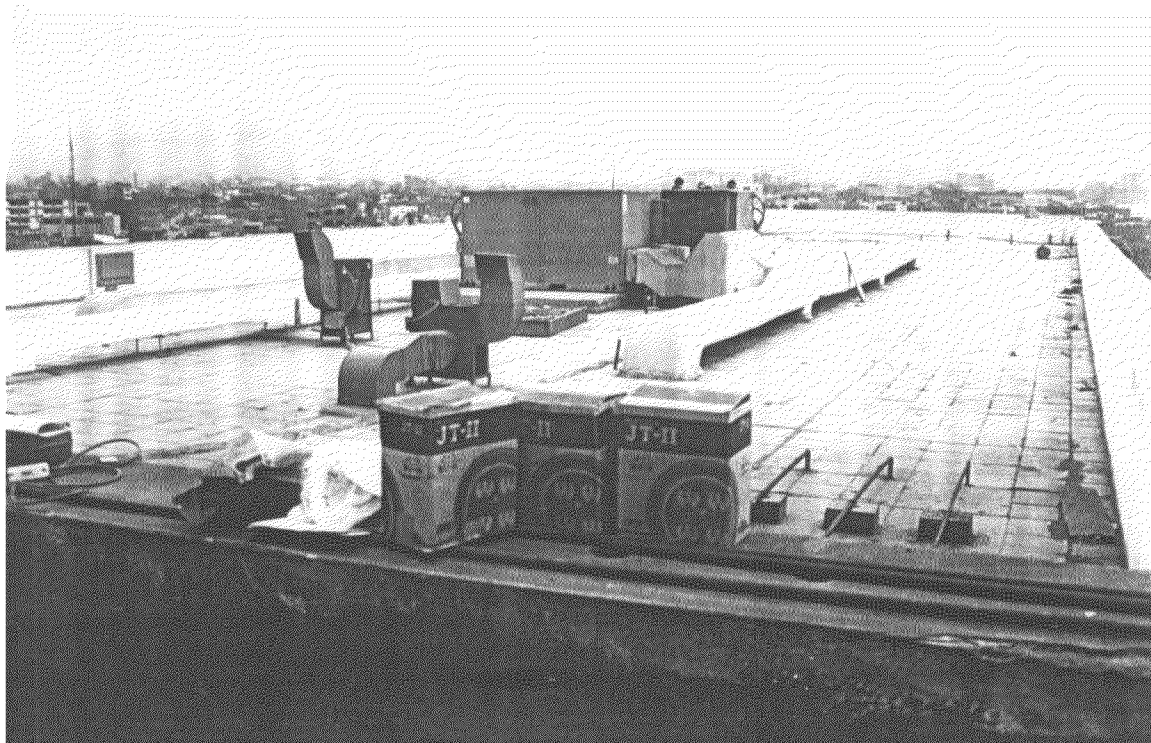
FOTO No. 13: HOSPITAL NACIONAL "GUILLERMO ALMENARA IRIGOYEN", VISTA DE LA AZOTEA DEL EDIFICIO ALA ESTE DEL PABELLON "A".
