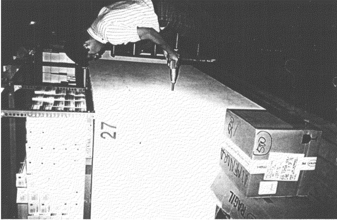
**FOTO No. 3: HOSPITAL NACIONAL "GUILLERMO ALMENARA IRIGOYEN". PABELLON PRINCIPAL, EDIFICIO ALA ESTE, SOTANO. PRUEBA DE ESCLEROMETRIA EN UNA ZAPATA DE ALMACEN DE DROGAS.**
