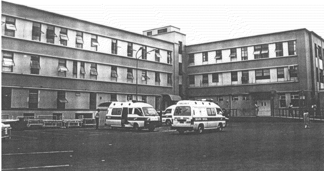
FOTO No. 3: HOSPITAL NACIONAL “GUILLERMO ALMENARA IRIGOYEN”, EDIFICIO ALA ESTE DEL PABELLON PRINCIPAL, FOTO TOMADA DESDE EL PATIO DE AMBULANCIAS. A LA IZQUIERDA SE PUEDE NOTAR LA JUNTA QUE DIVIDE A LOS EDIFICIOS ALA ESTE Y CENTRAL.
