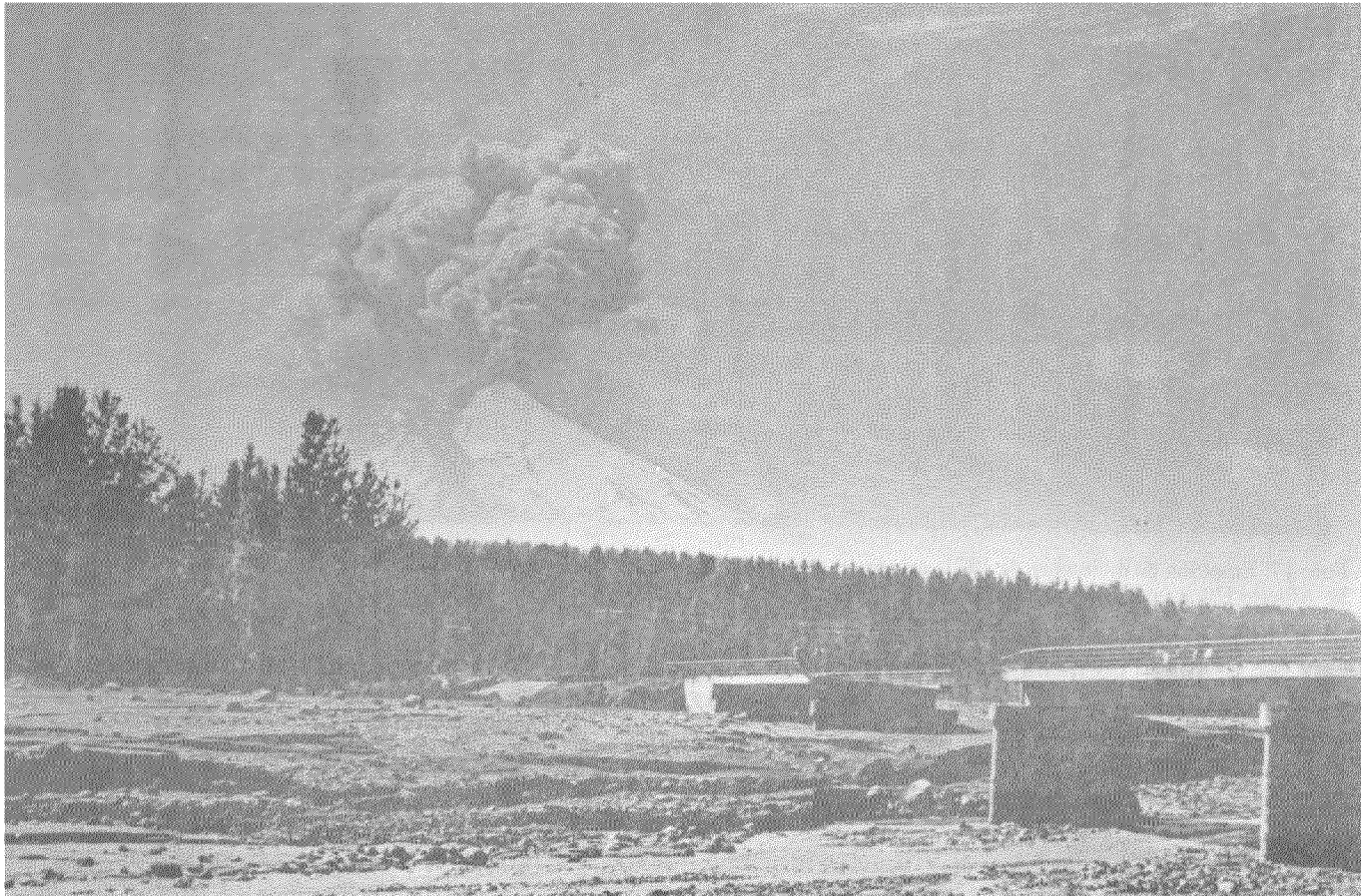
Foto 16 Erupción del volcán Villarrica, en diciembre de 1971, la avalancha que bajó por el río Correntoso destruyó el puente que unía Villarrica con Pucón.
