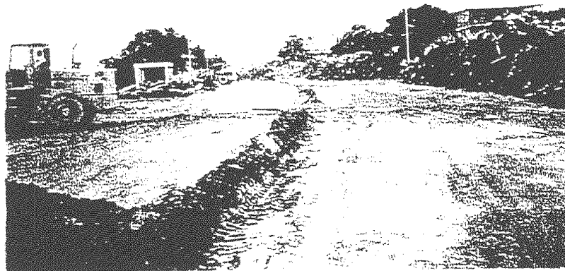
Removiendo el material depositado en la av. Soubllette frente al Cementerio de La Guaira. Foto 14
