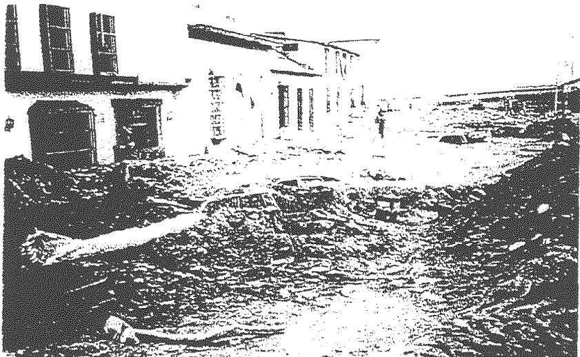
Depósito de material arrastrado por la quebrada Osorio, hacia el oeste en la av. Soubllette Foto 10
