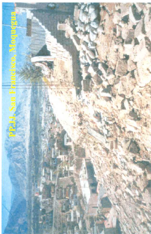
Imágenes de viviendas de tipo A, de mala calidad, ubicadas en el Pueblo Joven San Francisco, de Moquegua. Se observa que edificaciones construidas en suelo inclinado han colapsado.
