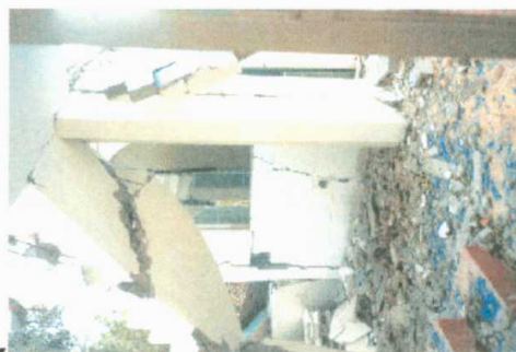
Imágenes de construcciones de tipo C ubicadas en diferentes sectores de la ciudad de Ilo y que presentan destrucción parcial en la mayor parte de las edificaciones debido al tipo de suelo sobre el que fueron construidas. La Imagen inferior derecha presenta agrietamiento y fisuras sobre la superficie del suelo, rumbo N 40° E.
