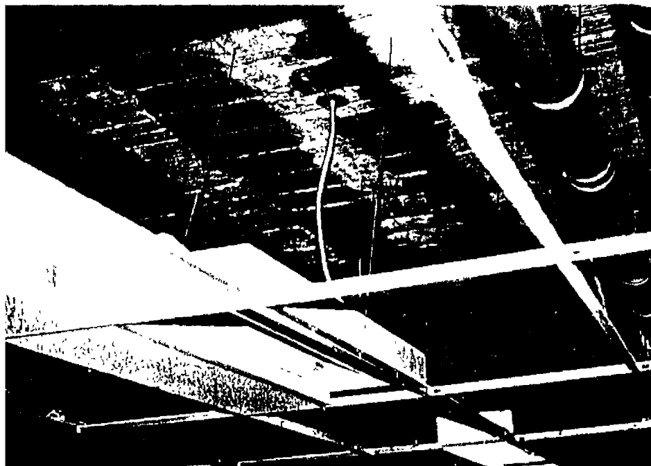
FOTO 4.20 SISTEMA DE SUJECION DEL FALSO TECHO (PLAFONES Y LAMPARAS)
