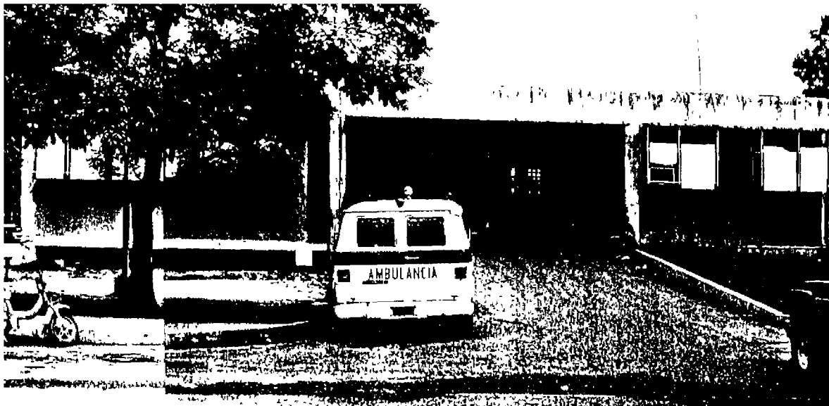
FOTO 4.23 ENTRADA DE EMERGENCIAS (CUERPO C)
