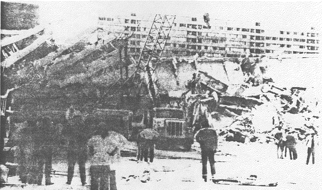
Foto 15.- Edificación de 12 pisos construída mediante el uso de muros de corte o pantallas y losas de concreto armado que sufrió volcamiento total durante el terremoto de la Ciudad de México en el año 1985, debido a la esbeltez y a efectos torsionales. (foto Salvatierra)
