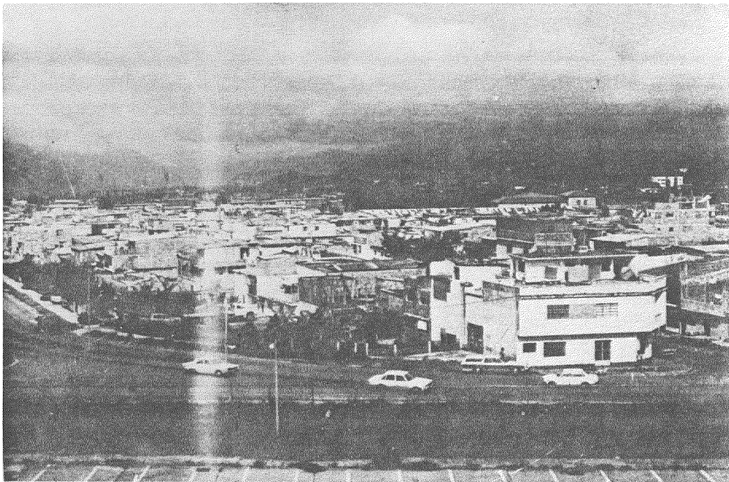
Foto 25.- Barrio Campo de Oro conformado por edificaciones aporticadas sin diseño sísmico de 1, 2 y 3 pisos. Algunas construcciones están catalogadas como precarias estructuralmente, su vulnerabilidad compromete la seguridad del HULA.
