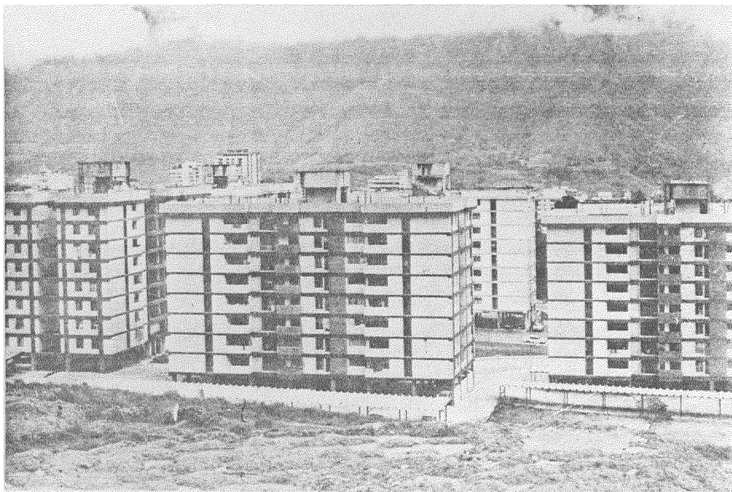
Foto 29.- Las 6 torres de las Residencias Las Marias presentan planta libre y tanque de suministro de agua en la azotea. El nivel de vulnerabilidad de este conjunto residencial es muy alto si tomamos en consideración que están localizadas en una zona de sedimentación profunda de h = 130 mts.
