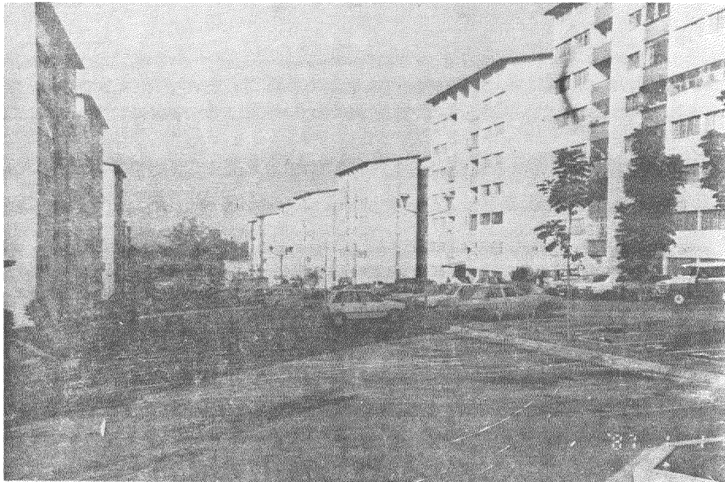
Foto 35.- Conjunto Residencial Monseñor Chacón, integrado por 16 torres de apartamentos localizado en la Avenida Las Américas, estructurados con paredes de corte y paredes transversales de refuerzo.
