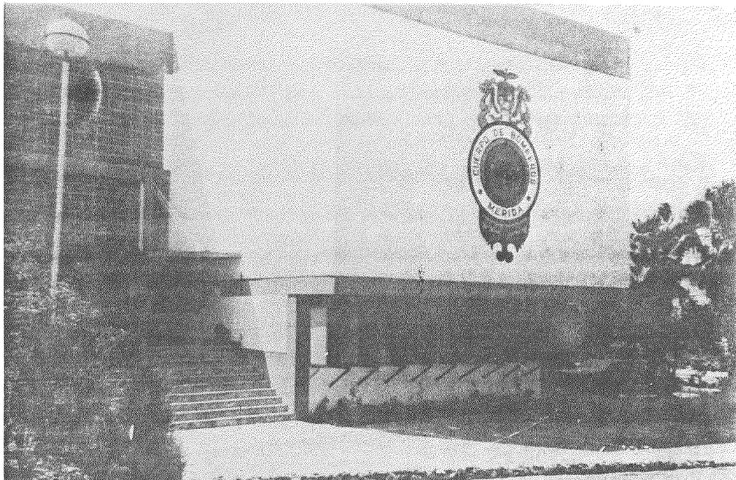
**Foto 37.- Vista parcial del Cuartel de Bomberos de Mérida en la cual se observan paredes a doble altura en el área del gimnasio y la losa flexada en el área de acceso principal.**
