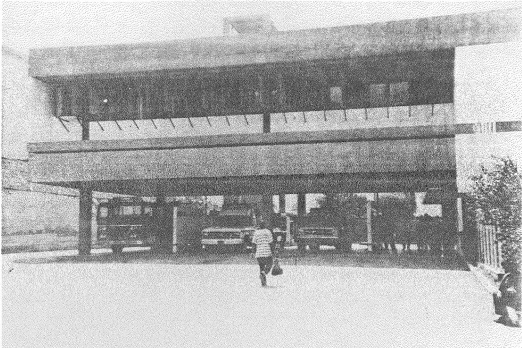
**Foto 36.-Edificio del Cuerpo de Bomberos de Mérida. Cuerpo de dos plantas correspondientes a dormitorios en primer piso y estacionamiento de unidades de combate en planta baja.**
