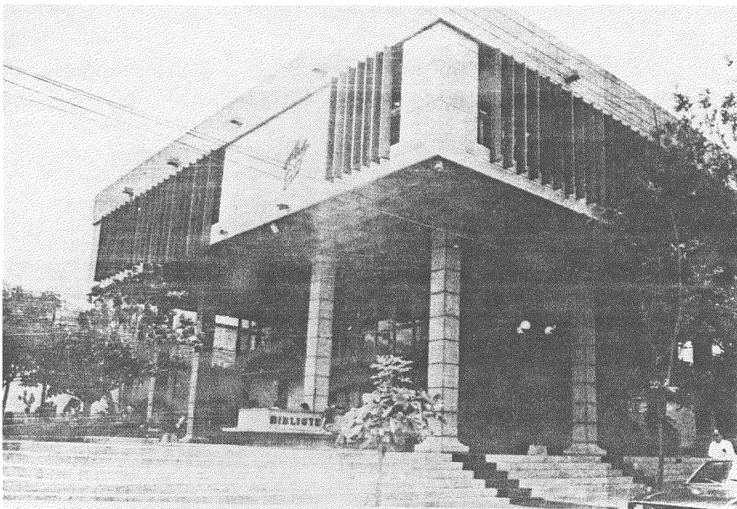
Foto 40.- Vista de la fachada sur de La Biblioteca Bolivariana, en la cual se puede apreciar la esbeltez de las columnas periféricas a doble altura que pueden ocasionar un efecto de torsión y volcamiento de la edificación.
