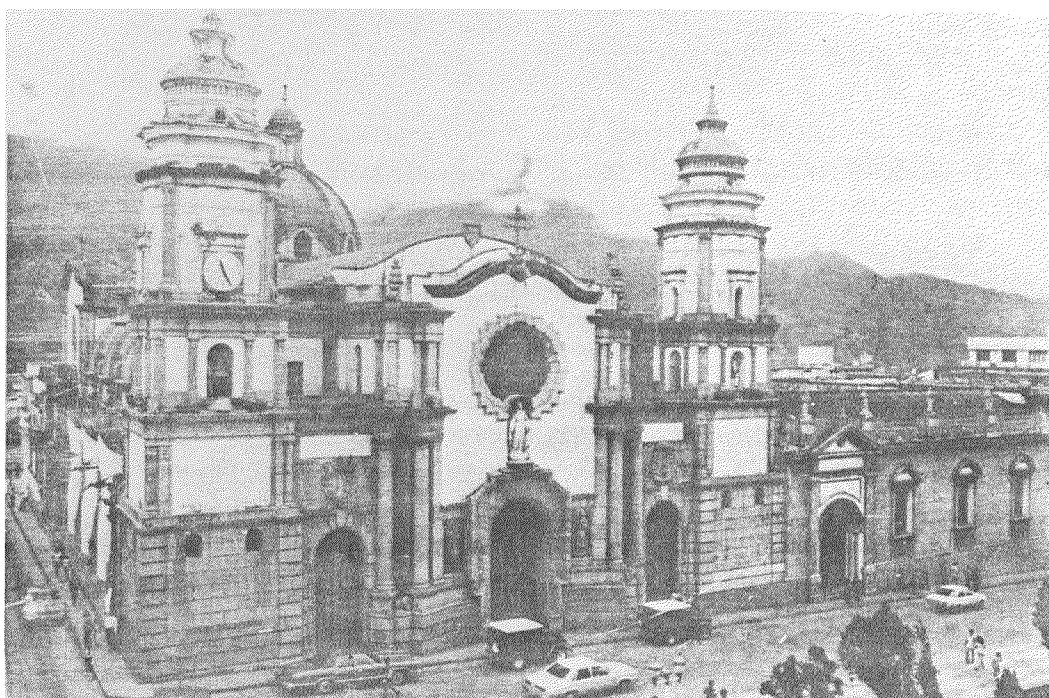
Foto 41.- Vista de la fachada norte de la Catedral Metropolitana de Mérida apareada con la sede del Museo Arquidiocesano generándose una alta vulnerabilidad por colindancia con probable daño en ambas torres por cambios de rigidez vertical.
