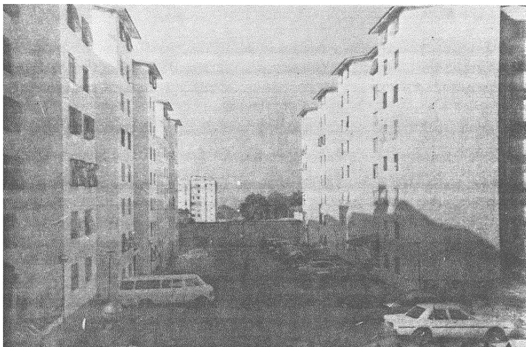
Foto 43.- Vista correspondiente al Conjunto Residencial Los Bucares localizado en la Avenida Las Américas, desarrollado mediante la utilización de un sistema combinado de elementos prefabricados vaciados en la obra.
