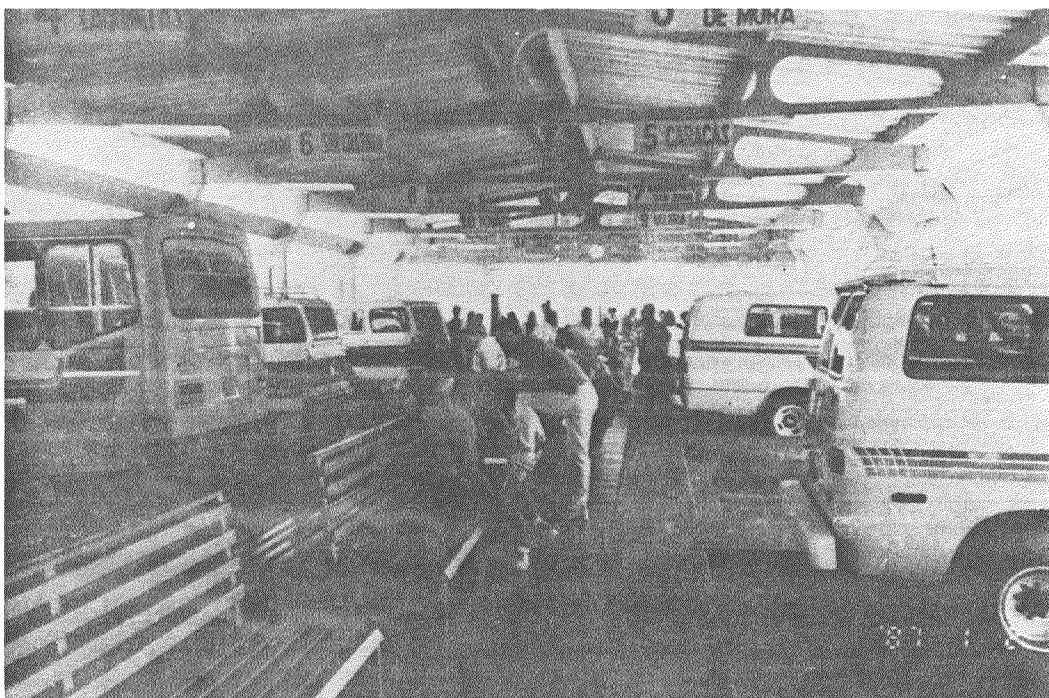
Foto 42.- Vista general del andén de rutas suburbanas del Terminal de Pasajeros de Mérida, construido mediante la utilización de un sistema prefabricado. La experiencia obtenida con los sistemas prefabricados ha demostrado que no es recomendable su uso en zonas sísmicas.
